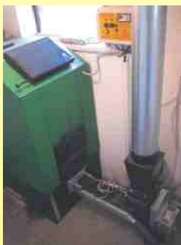
Peč s podkuriščem v kombinaciji s presipnikom in odvzemom iz silosa.
