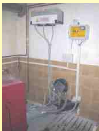
Avtomatika nadzira delovanje gorilnika. Poleg tega je montiran tudi trikratni protipožarni varovalni sistem.
